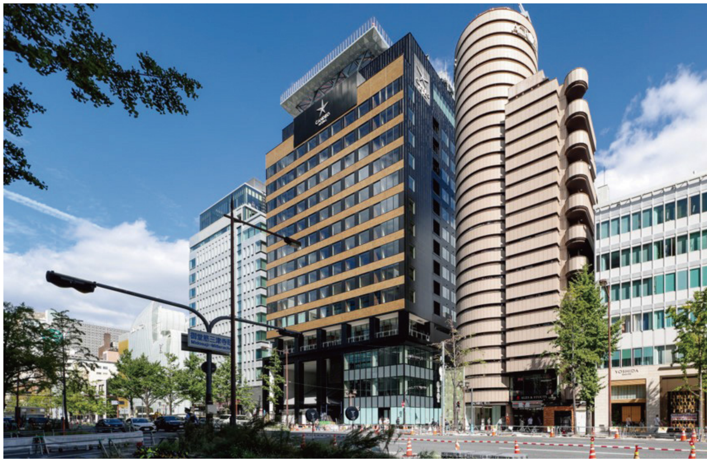
東京建物三津寺ビルディング／カンデオホテルズ大阪心斎橋
